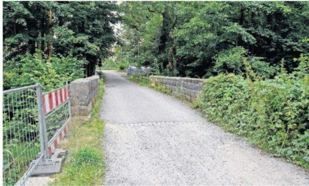
Ziel der Sanierung an der Talstraße ist es, die Tragfähigkeit zu erhöhen und die Fahrbahn zu verbreitern, um landwirtschaftlichen und Versorgungsverkehr mit erforderlichen Lasten und Breiten zu ermöglichen.
