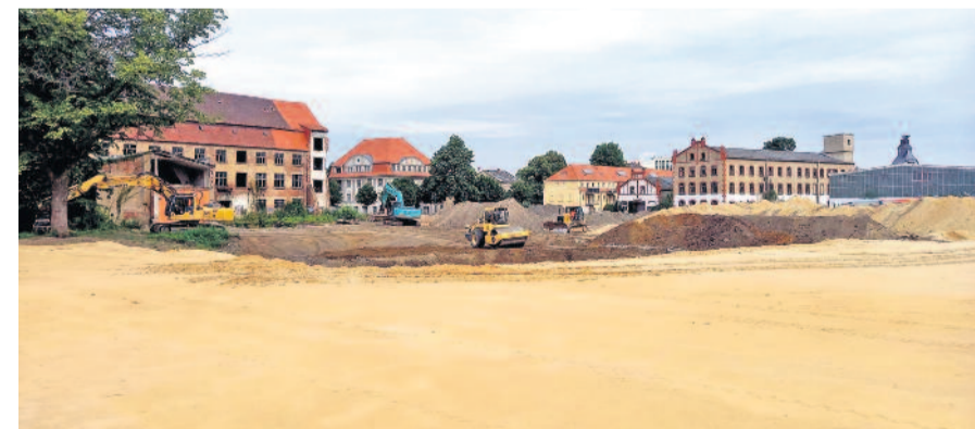
Im März 2024 waren die Arbeiten auf dem ehemaligen Eschbach-Areal noch in vollem Gange. Nun warten Landkreis und Schulleitung auf die Baugenehmigung, damit das Projekt voranschreiten kann.
